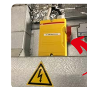
Ventilationen standses ved at slå det lille røde håndtag nedad.
