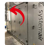
Den gule afbryderboks er placeret ovenpå de grå skabe.
